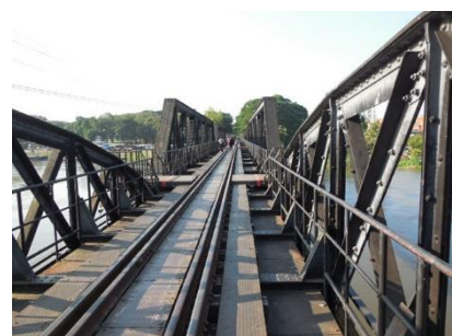
泰緬鉄道のクウェー川鉄橋
